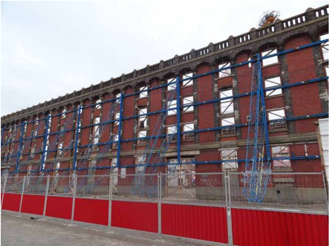
Fig.22 La Halle aux sucres en cours de transformation sur le Môle 1
