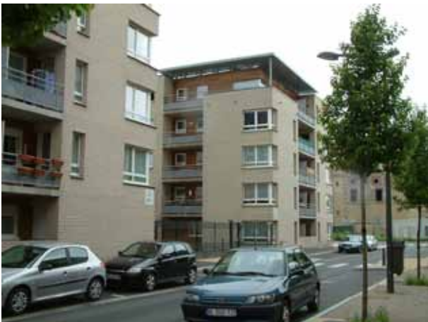
Fig.27 rue du Jeu de Mail, les nouvelles constructions face au bâtiment de la figure précédente
