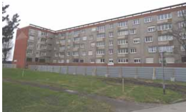
Fig.39 Barre d'immeuble HLM construite dans les années 60
