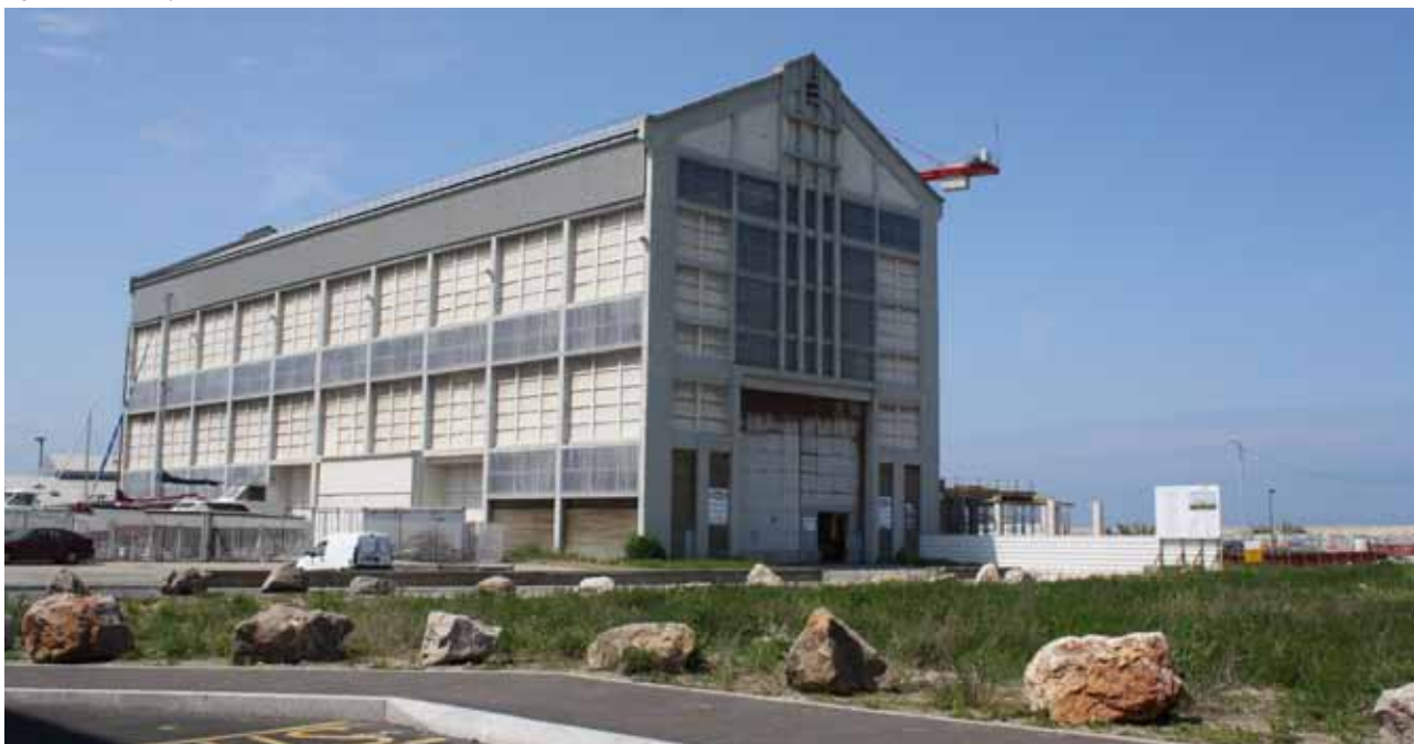
Fig.18 L'atelier de préfabrication 2 - FRAC
