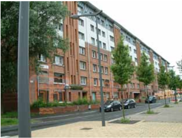
Fig.26 rue du Jeu de Mail : une résidence vouée à la démolition. Les tags sont le résultat du travail des habitants et de l'artiste Jessika Laranjo. Le nouvel aménagement des trottoirs est réalisé à gauche.
