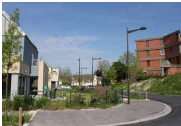
Fig.45 Face à face entre les maisons de la Foncière logement et les immeubles de Jean Renaudie avec les maisons mitoyennes sous toiture à double pente à l'arrière-plan.
