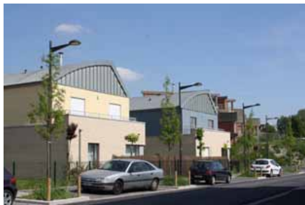
Fig.44 Les maisons de la Foncière logement sur l'ancien stade, on distingue les immeubles de Jean Renaudie à l'arrière-plan
