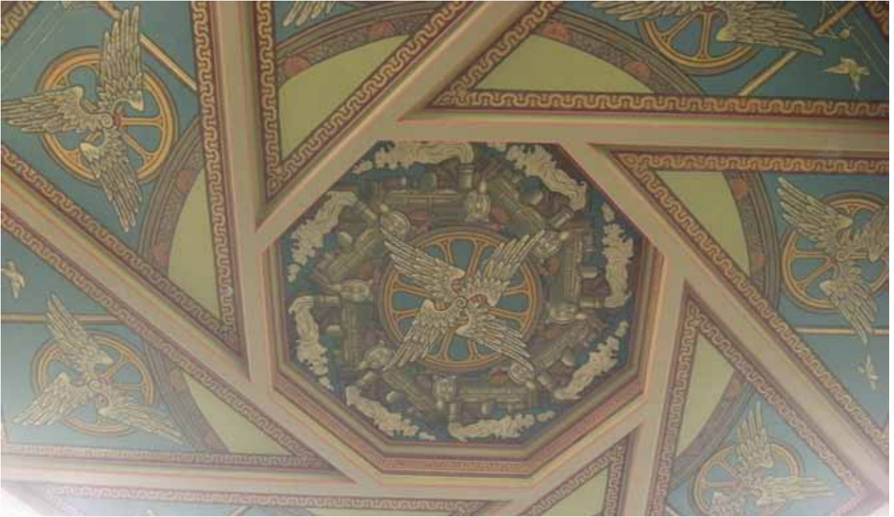
Plafond de la gare de Gand-Saint-Pierre
