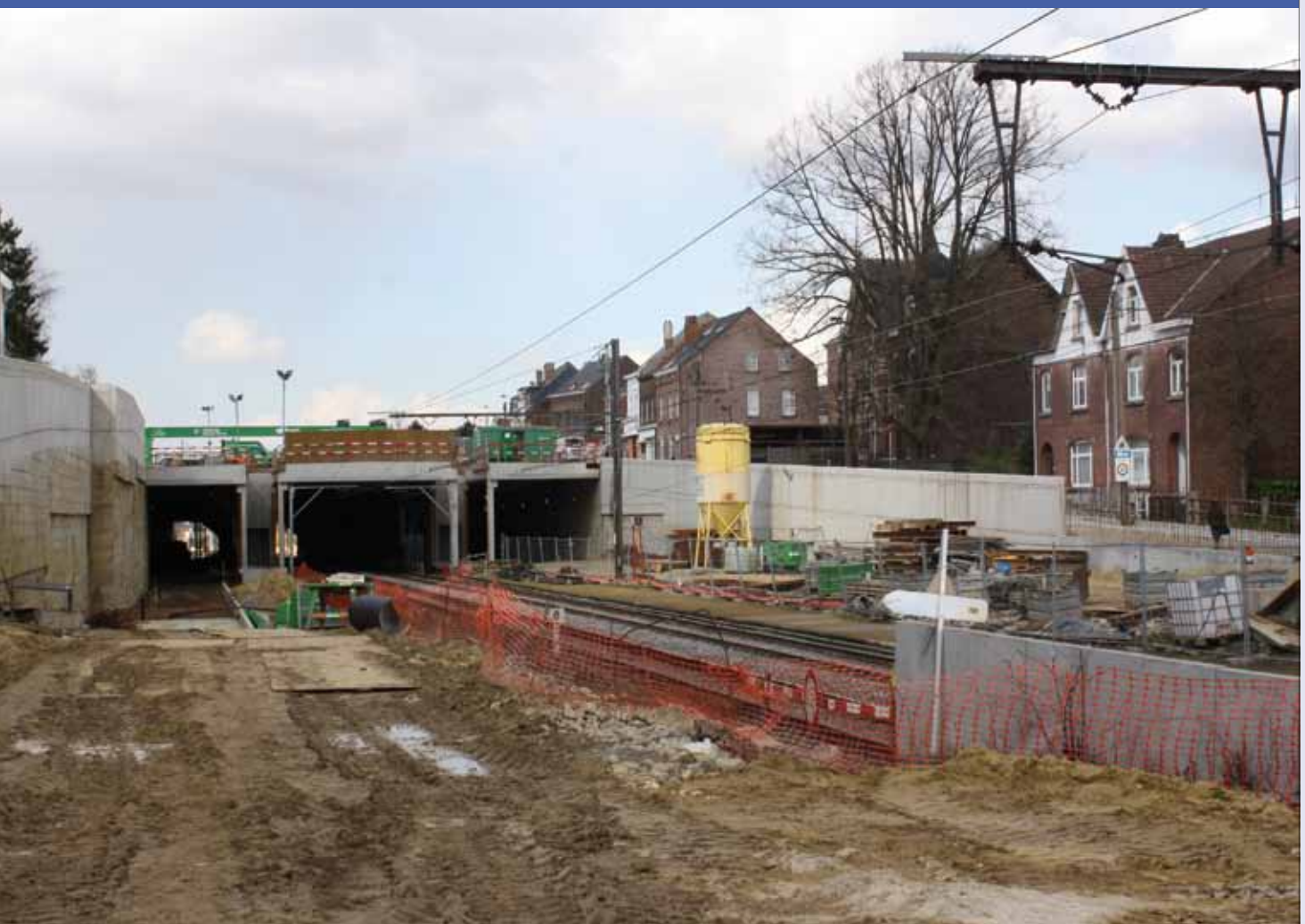
L'aménagement d'une dalle de 120 m de long au-dessus des voies permettra de créer une nouvelle place publique dans le centre de Rixensart. @ X. A.
