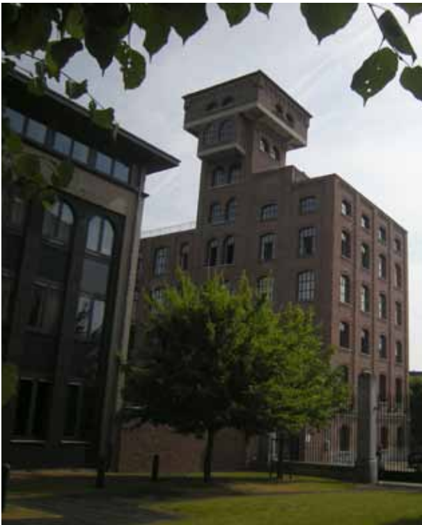
Fig.25 Les silos et le nouveau bâtiment du collège sur la gauche
