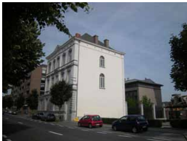
Fig. 23 La Maison Descamps et le nouveau bâtiment du collège Saint-Julien à droite
