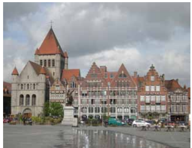
Fig.35 Le côté nord-ouest de la Grand-Place
