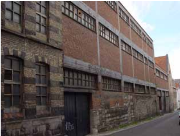
Fig.47 Les bâtiments de la rue Claquedent avant leur rénovation © Bertrand Feys
