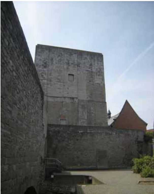
Fig. 2 - La tour Burbant et sa chemise
