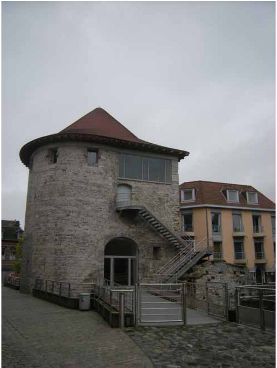
Fig.33 Le Fort Rouge vu depuis l'intérieur de l'îlot
