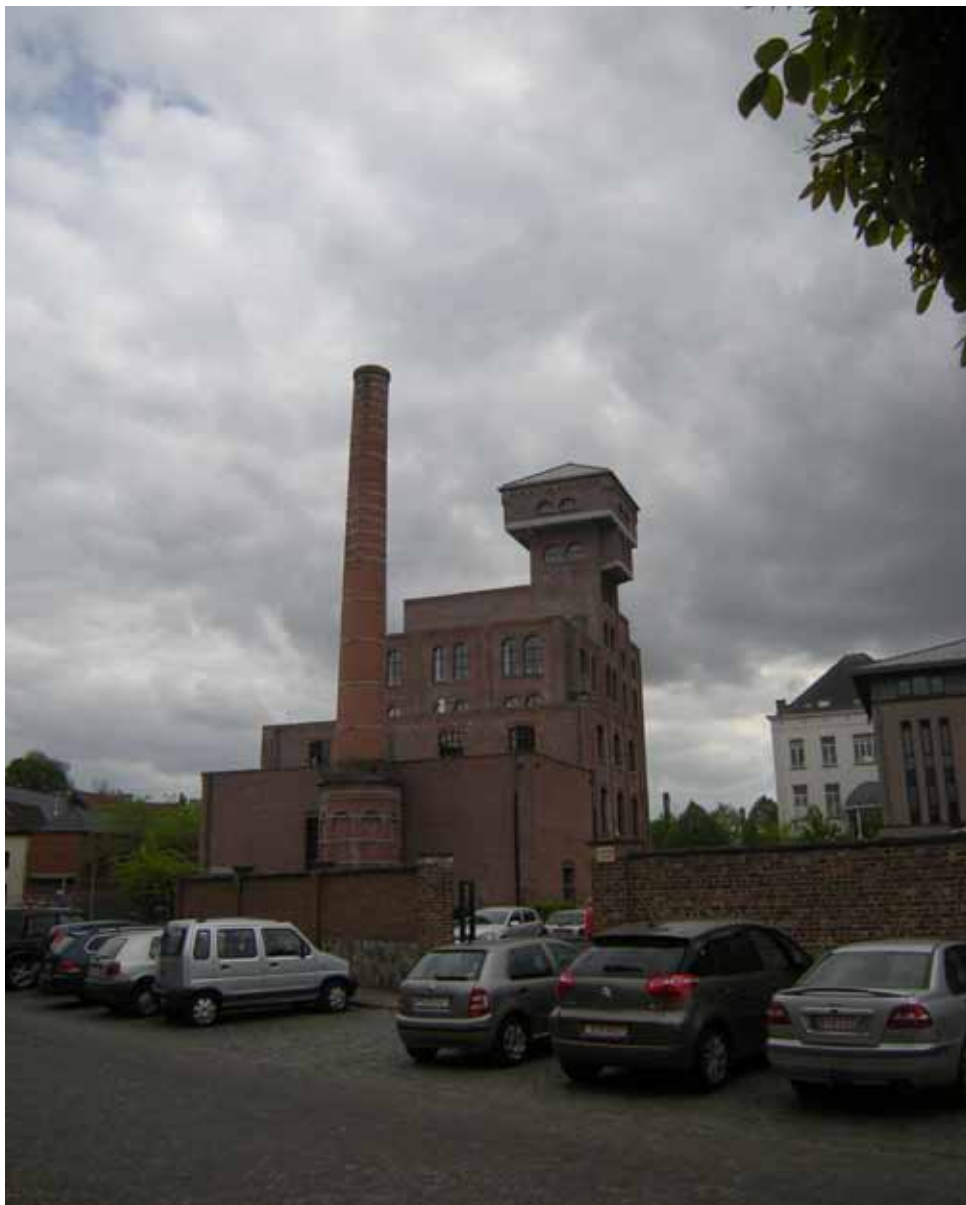
Fig. 24 Le site vu depuis la rue de Dendre, avec la cheminée en avant-plan
