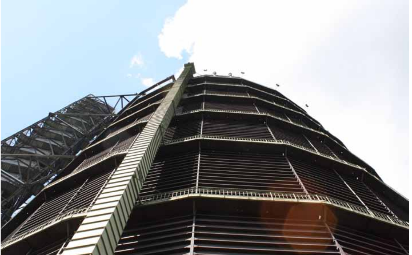
Fig.8 Le gazomètre d'Oberhausen
