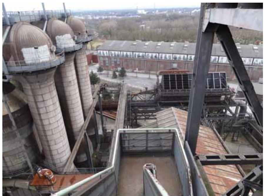
Fig.22 Passerelle vers le sommet du haut fourneau n°5
