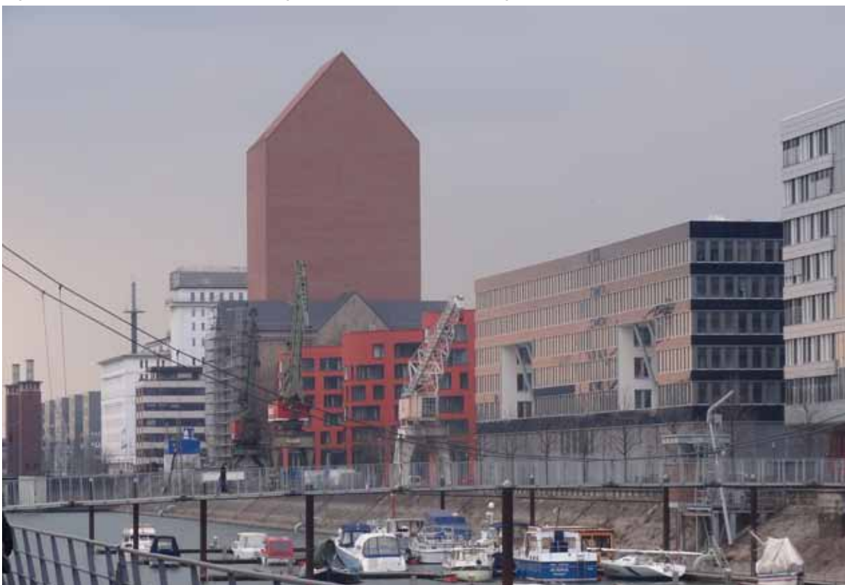
Fig.20 La rive nord du port de Duisburg, avec le silo des archives régionales
