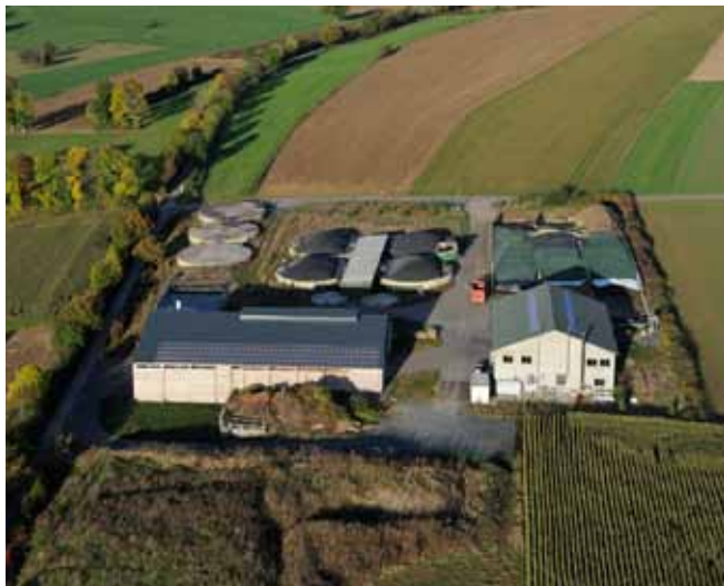
Fig.42 La centrale à biogaz © d'Millen asbl
