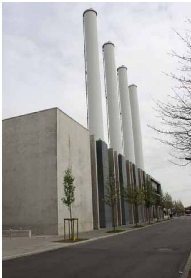
Fig.39 La centrale de cogénération
