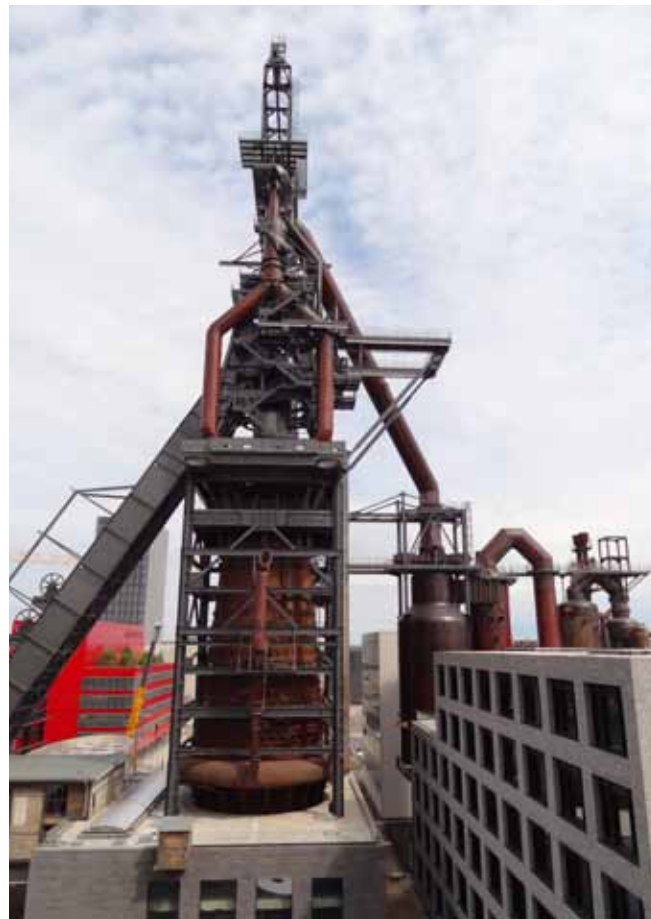
Fig. 20 Passé et présent s'entremêlent sur la Terrasse des Hauts Fourneaux
