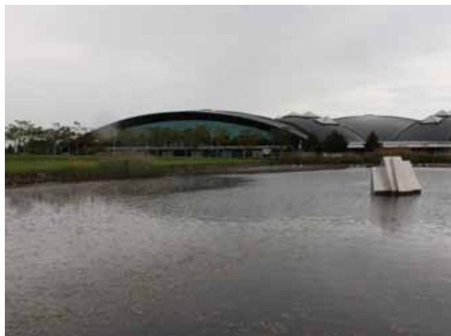
Fig.38 Le bassin de rétention du Parc central et la « Coque »
